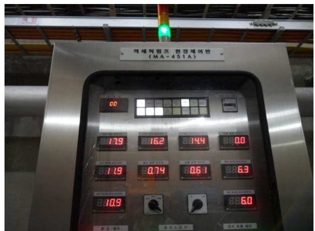
역세펌프 판넬 전류지시계 표시값 보수 완료
