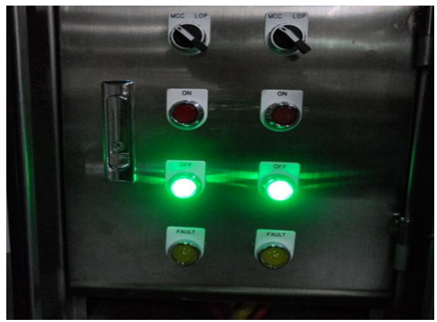
활성탄흡착지 2계열 펌프보수 완료
