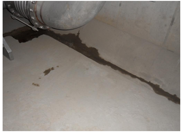
탈수기측 공동구 청소 완료
