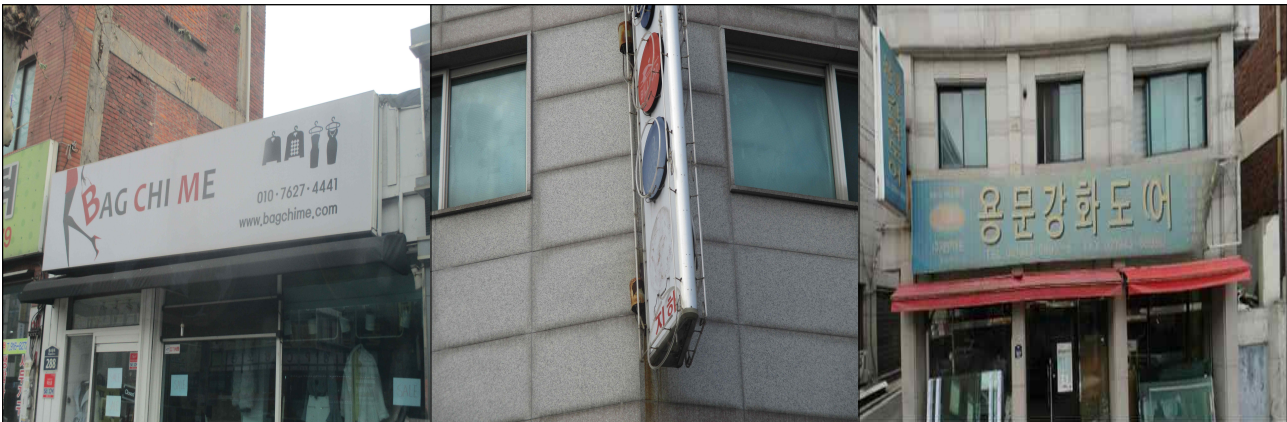
동소문로 288 (가로간판 아래부분 미고정 상태)
