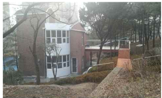
금옥마을 조성 공사 모습
