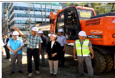
빗물저류조 설치공사 현장 점검
