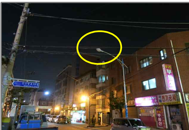
17 위치 긴고랑로 135 (중곡4동 62-35) 내용 가로등 부점등 (도로과)
