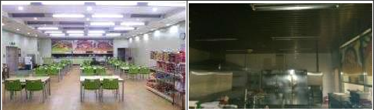
지하식당 (소방시설 개선 필요)
