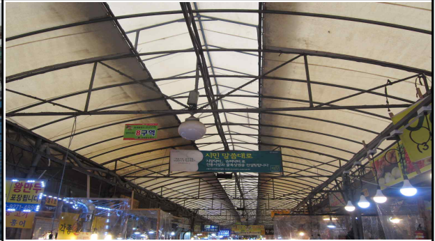
비가리개 내부 전경
