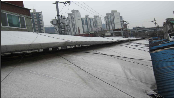
비가리개 천장 전경
