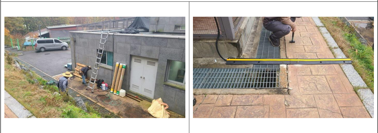
CCTV 라인 설치 공사
