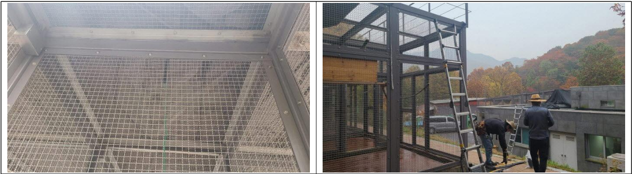
검역격리사 통로5번 카메라 라인 설치
