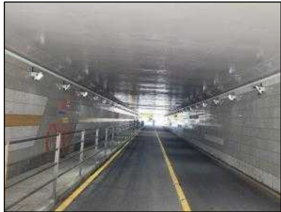
- 나들목 리모델링 후
