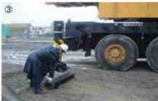
③ 건설기계 설치 작업 + 아우트리거 버팀목 등
