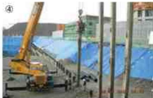
④ 양중작업(H-Pile) 실시
