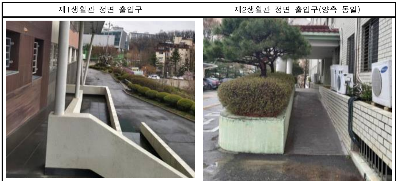
[그림 2] 출입구 경사로 손잡이 미설치
