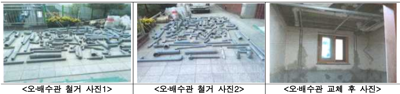
[그림 3] 오·배수관 철거 및 시공사진
