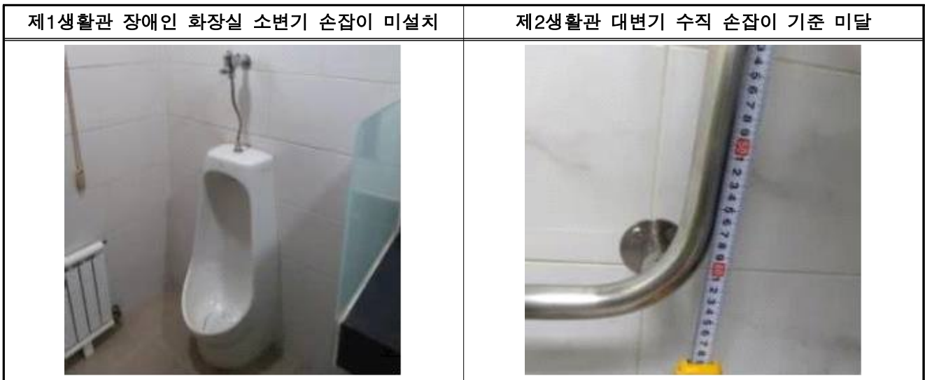
[그림 3] 장애인 등의 이용이 가능한 화장실 손잡이 기준 미달(1·2생활관)
