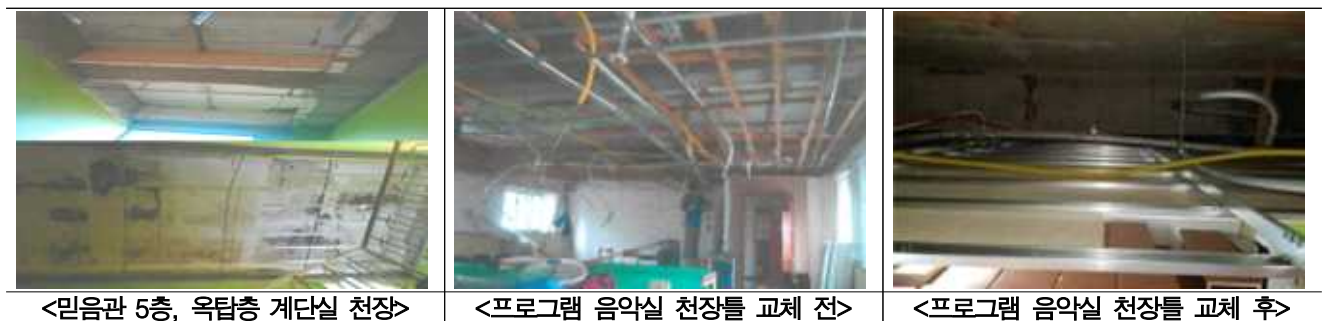
[그림 2] 신규공종(경량철골 천장틀 철거 및 시공) 발생현황
