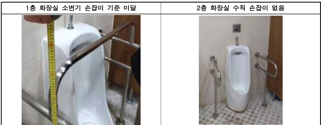
[그림 4] 장애인 등의 이용이 가능한 화장실 손잡이 기준 미달 등(소담재)
