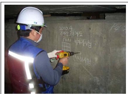
탄산화 시험 전경
