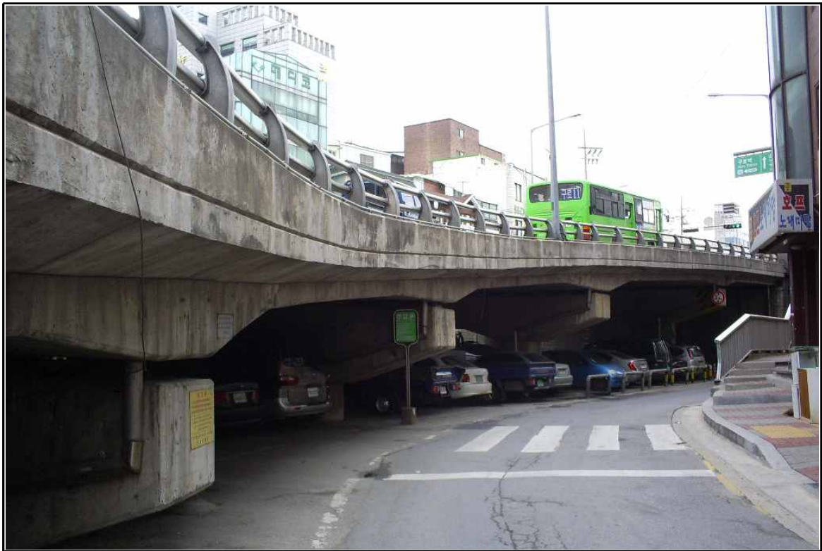
가마산고가차도 상부 및 측면전경
