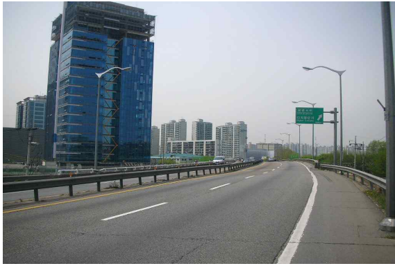
교량 상부 전경
