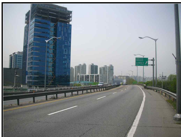
시설물 상부 전경
