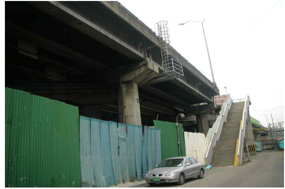
교량 측면 전경
