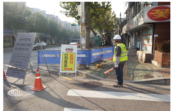
교통신호기 공사(연간단가) 작업사진
