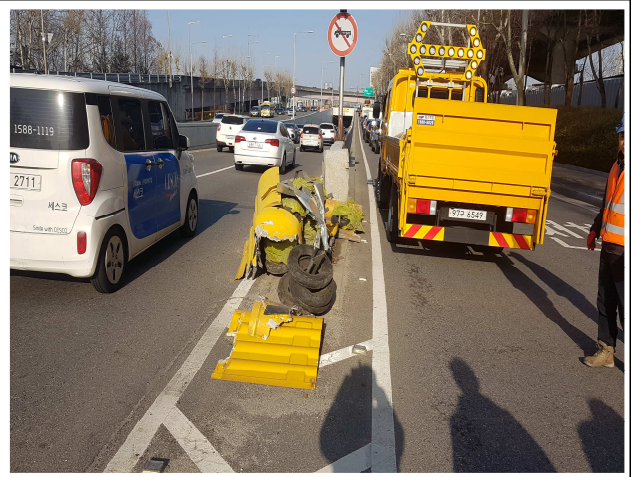
사진설명: 사고 후 충격흡수시설 및 장애물 표적표지 전파
