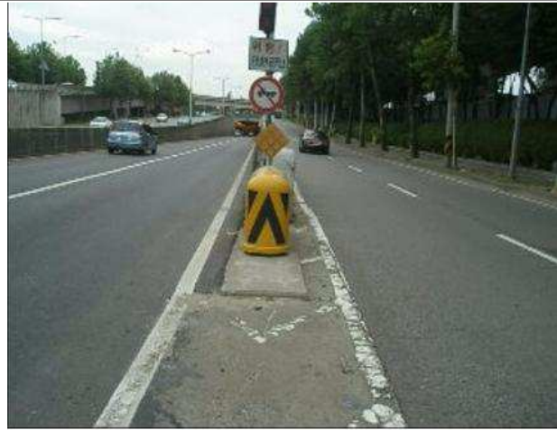
사진설명: 사고전 충격흡수시설 및 장애물 표적표지 현황사진
