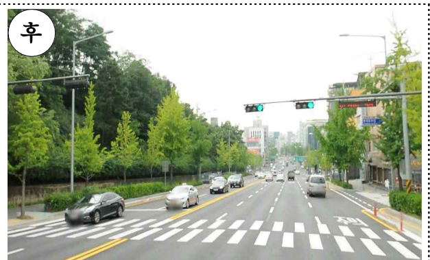
신호등주 설치 후(송파구 오금고 정문)
