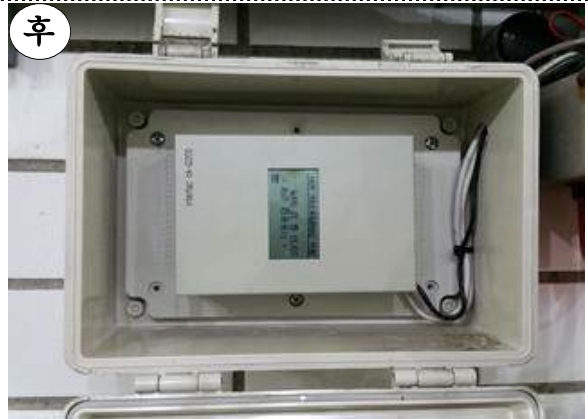
강남구 일원터널 보도 인터폰 교체 후
