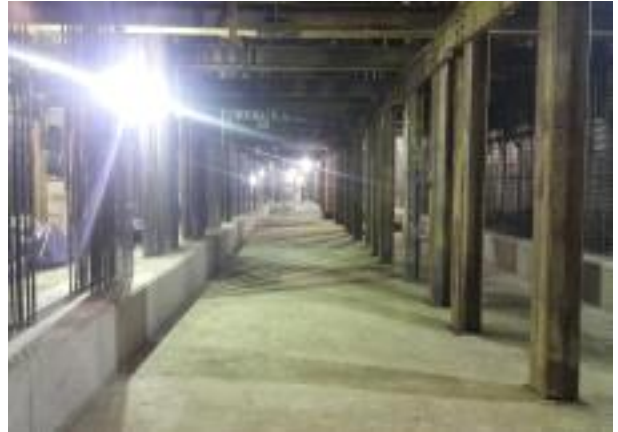
〈본선개착 구조물 공사〉
