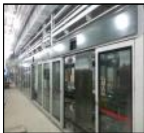
정거장 안전문 설치
