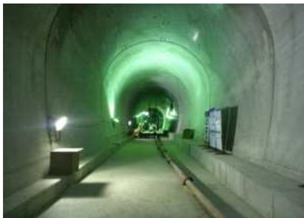
〈NATM 터널 구조물 공사〉
