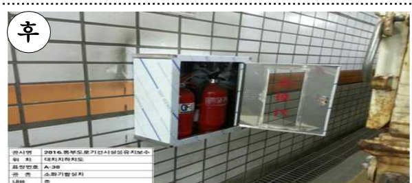
지하차도 소화기함 교체 후
