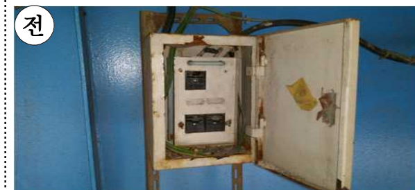
교량 내부점검등 분전반 교체 전
