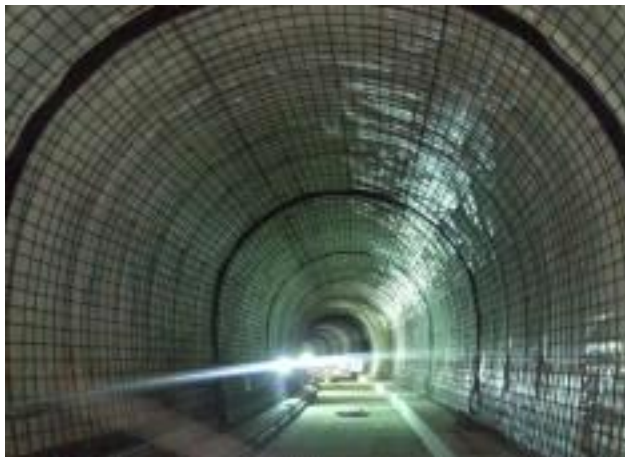
〈터널 구조물 공사〉
