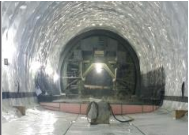
〈터널 방수 공사〉
