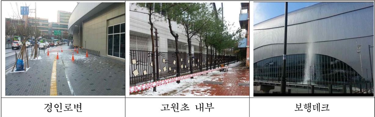
돔구장의 지붕 면적은 매우 광활하여(30,000m<sup>2</sup>) ▲스노우가드에 눈이 모여 있다가 한꺼번에 떨어지는 현상 발생, ▲거터(gutter)에 열선이 미설치 되어 눈이 쌓이는 역할, ▲열선이 끝단 부분에만 설치되어 제설기능 수행 불가 등 현재 설치된 스노우 가드 및 열선으로는 낙설방지가 미흡한 상황이며,
