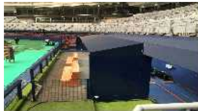
[안전] 선수위험 → 덕아웃 지붕 설치
