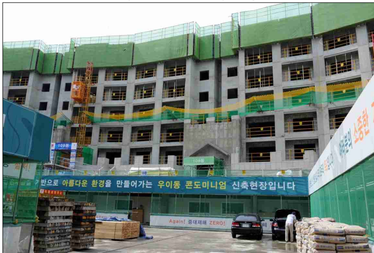
< 공정률 20% 이상의 공사현장 >
