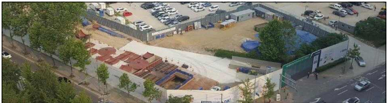
[그림 5] 공기정화시설 #1 수직구 굴착 현황('16.6현재)
