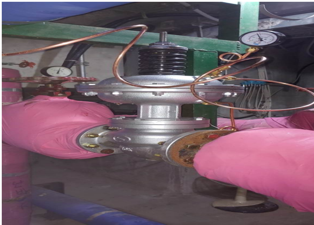
차압유량조절밸브 교체 후
