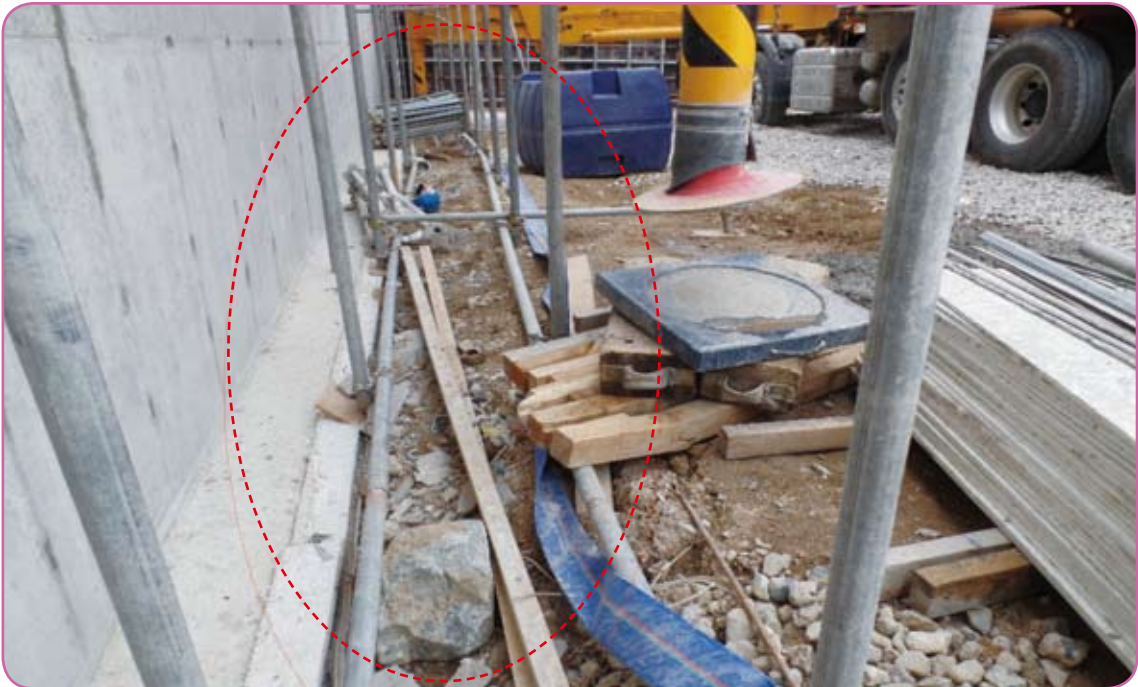
펌프카 아우트리거가 설치된 되메움 지반
