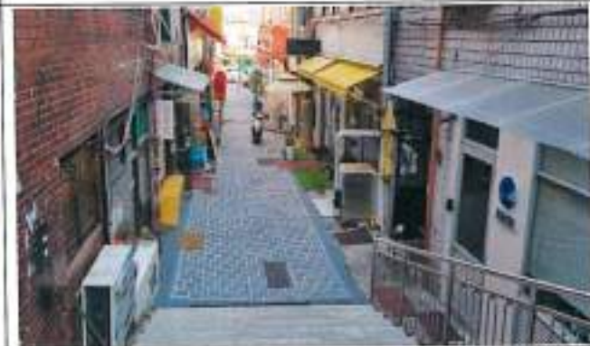
계단 공사 확인
