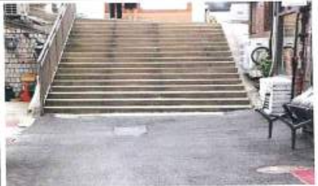
계단 공사 전
