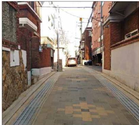
서울 은평구에 최근 조성된 향림 빗물순환마을의 주택가 골목 바닥에 도로 밑 지반까지 빗물이 스며들게 한 친환경 투수블록이 깔려 있다. 오른쪽은 가정집에 놓인 빗물을 모을 수 있는 ‘빗물저금통’.
