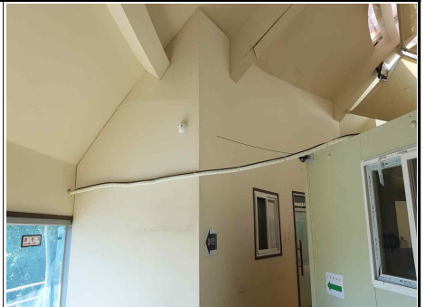
실외기 철거 후 배관 및 벽재마감
