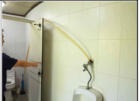
화장실 수변기 급수시설 정비
