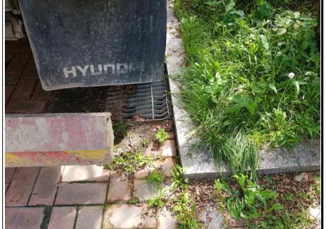
출입문 주변 배수로 및 스틸그레이팅 정비
