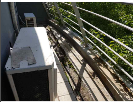
샤워실 외부 난간 배수로 정비
