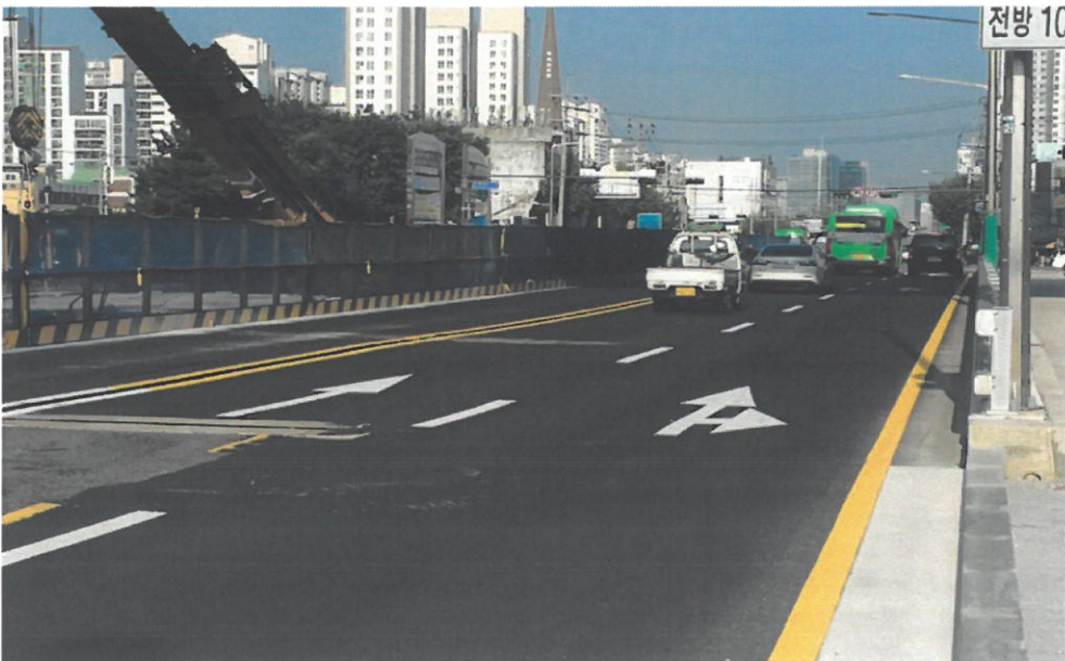
〈 교면포장(1층) 및 공사중 차선도색 〉
