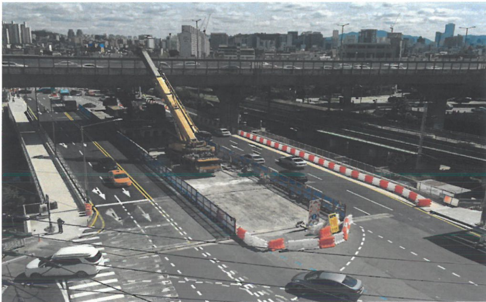
〈 안전시설물 설치 (빔가림막 휠스) 〉
