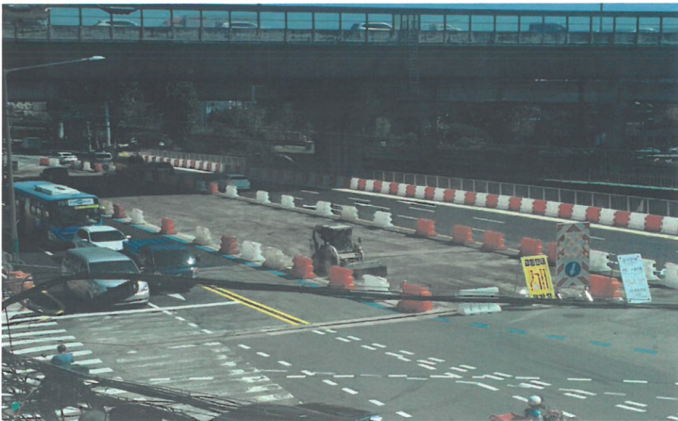
〈 안전시설물 설치 (PE 방호벽) 〉
