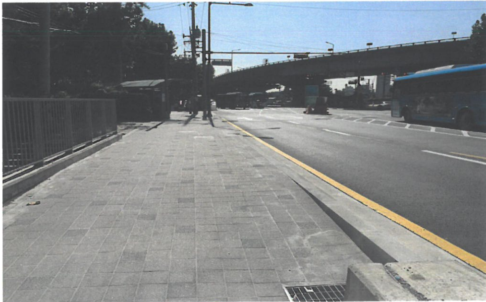
〈 보도포장 및 경계석 시공 〉
