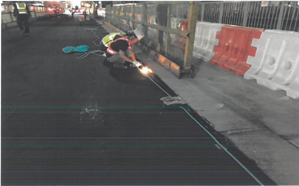
〈 교면방수 및 유공관 설치 〉
