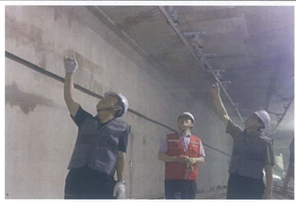
시공현장 안전 점검
