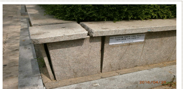
(구청장님 지시사항) 영동대로 216 하나은행 앞 화단 경계석 '16. 6. 17.까지 반드시 조치완료 하겠다고 함 (공원녹지과)
