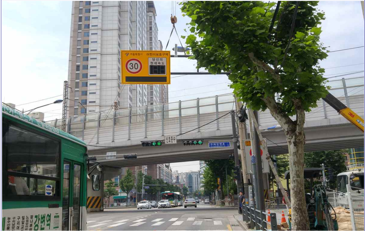
【 과속경보시스템 설치 중 】
