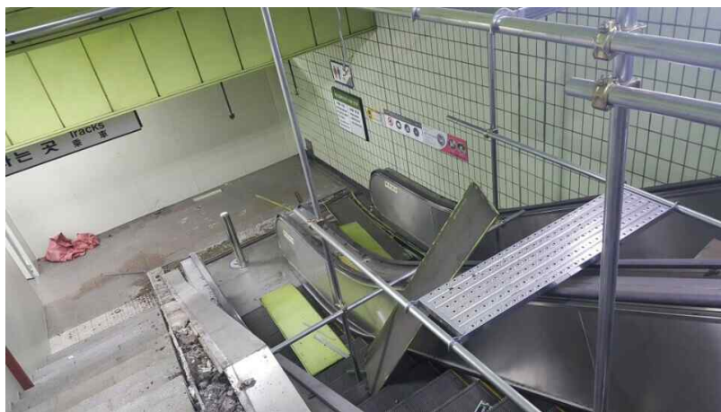
<사가정역 노후 에스컬레이터 교체 공사 현장사진>
