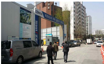
실증단지 신축공사 현장 방문
