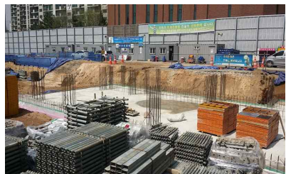
공사에 사용될 친환경 건축자재
