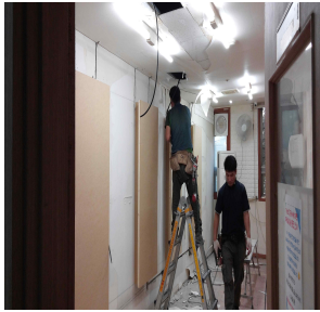
<이미용 시설> 공사 중
