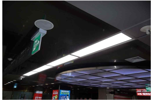
<영등포 지하상가 LED조명설비 설치>
