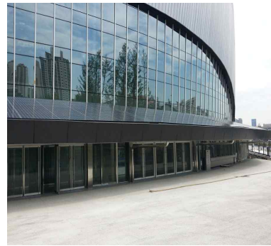
<고척스카이돔 캐노피 태양광>
