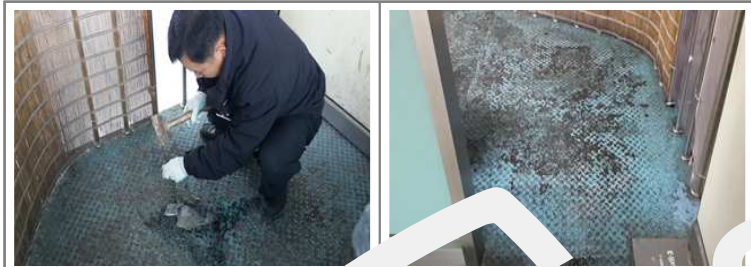
철 계단 얼음 제거 작업 중 철 계단 얼음 제거 후 모습
