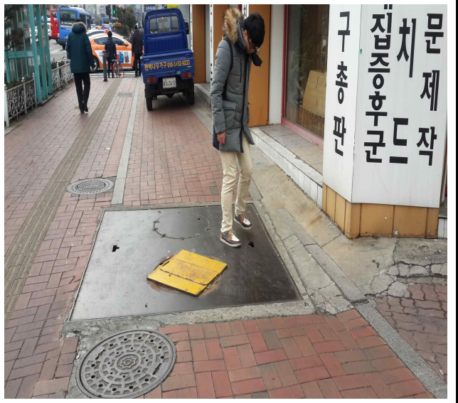
월계로변 간이 펌프장 맨홀(펌프실) 점검
