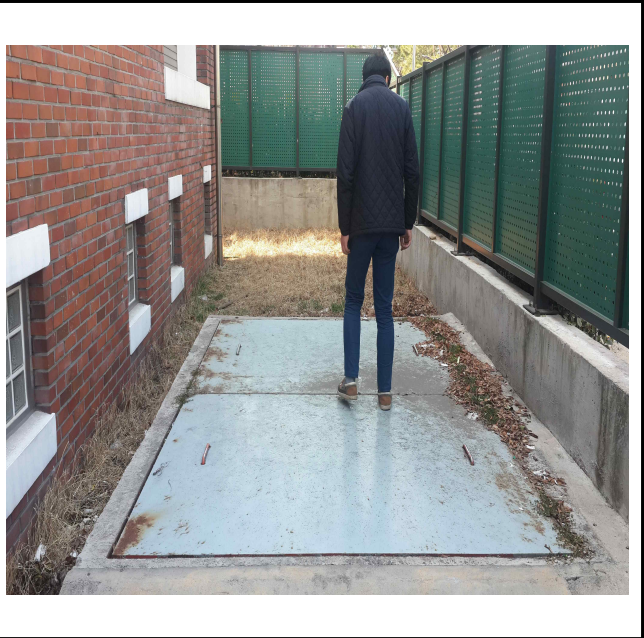
송중동 체류지 펌프장 맨홀(저류조) 점검
