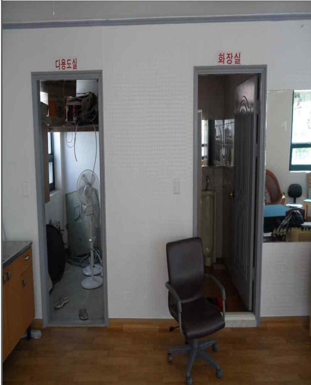
경로당 2층(유희공간 화장실 등)
