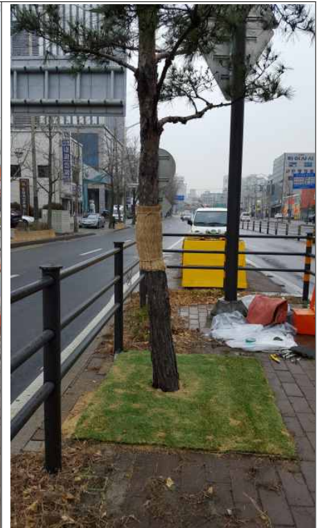
- 설치 후(인조잔디 설치) -
