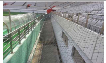
모트 추락방지망 설치
