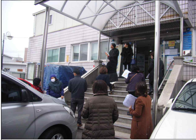
주민센터 출입계단 노약자용 손잡이 설치
