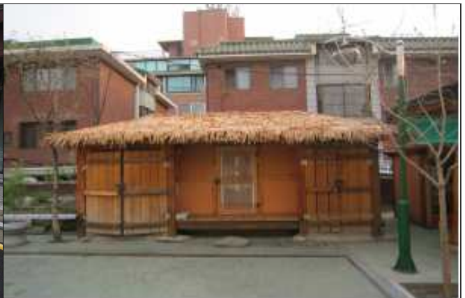
중곡1동 전통민속 체험관 지붕 인조짚 교체
