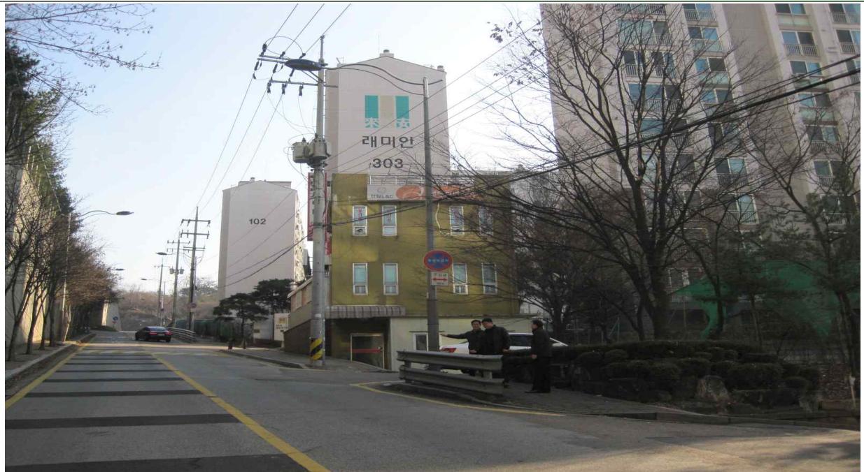
사진설명 독서당로55길 가로등주 교체(완료) 전경 【사진 2】
