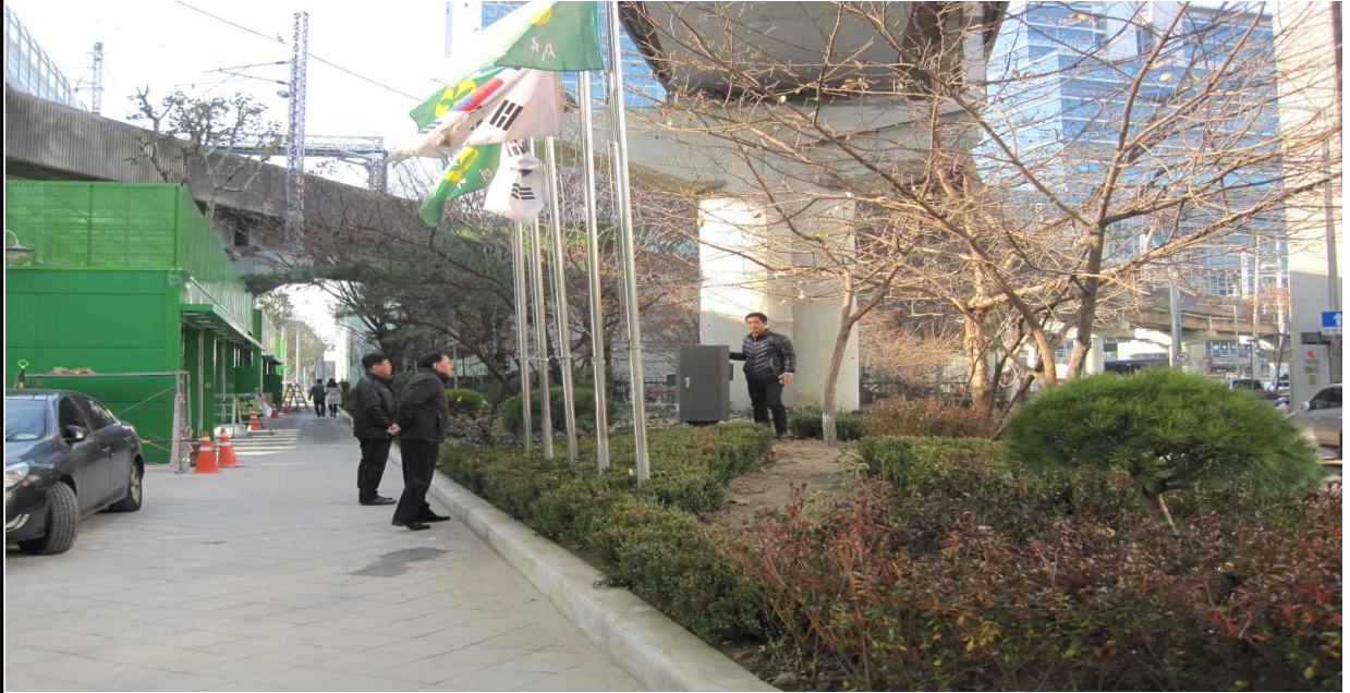
사진설명 성수동 수제화 공동매장 주변 분전함 이설(완료) 전경 【사진 1】
