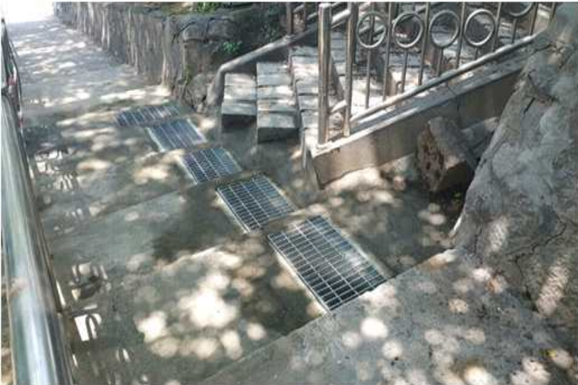
동작초교 등갯길 트렌치 설치 (후)- 산에서 내려오는 우수 처리
