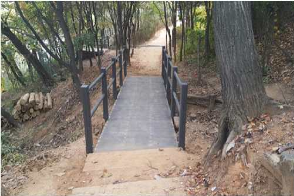
진입테크 상부 노후된 다리 정비 (후)
