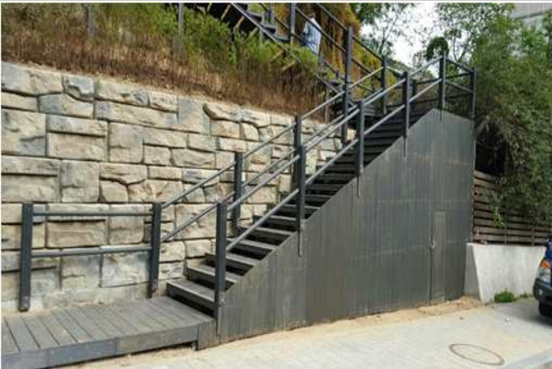
남부순환로 까치산생태다리 진입데크 설치 (후)
