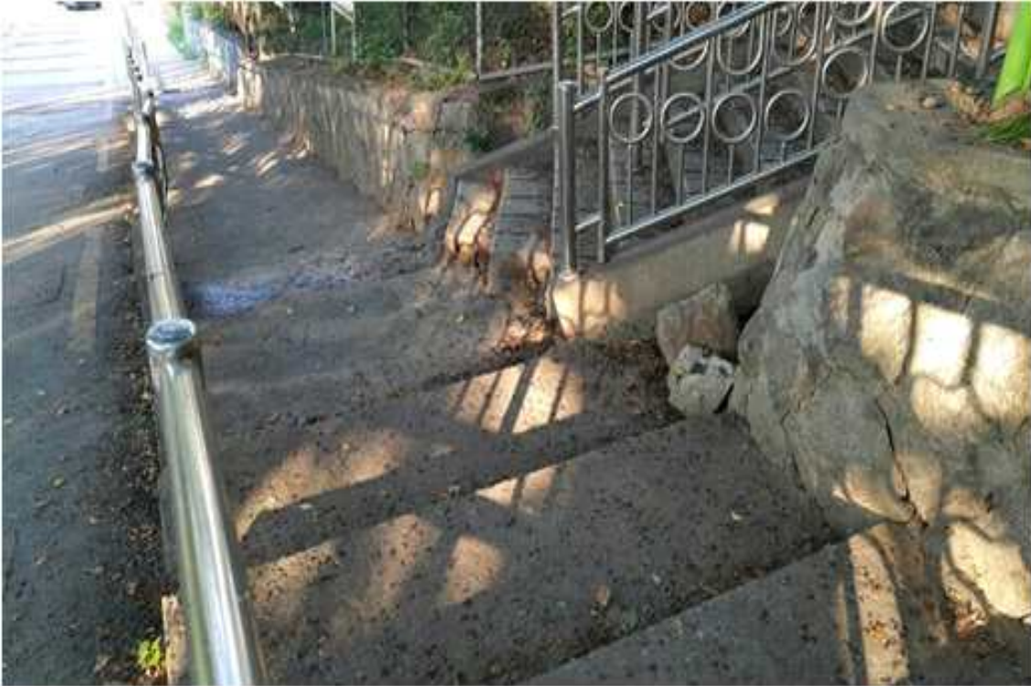
동작초교 등갯길 트렌치 설치 (전)- 산에서 내려오는 우수 처리
