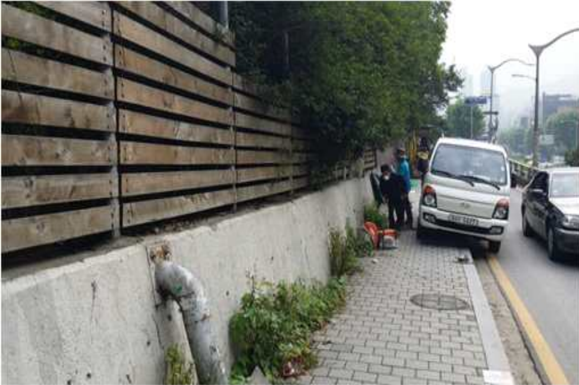
남부순환로 까치산생태다리 진입데크 설치 (전)
