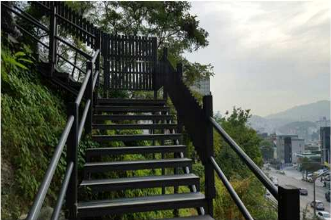
남부순환로 까치산생태다리 진입데크 설치 (후)
