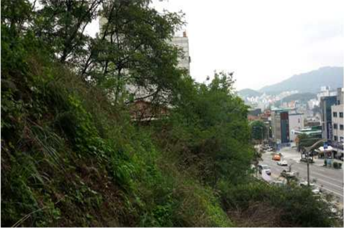
남부순환로 까치산생태다리 진입데크 설치 (전)
