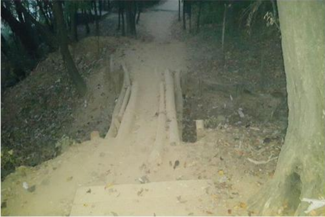
진입테크 상부 노후된 다리 정비 (전)
