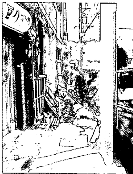
◇ 건축공사로 인하여 보도가 전면 차단된 경우 (오류동)
