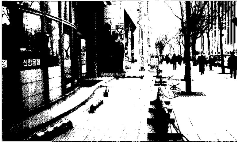
확장보도에 주차방지시설을 설치하였으나 오히려 통행장애물이 된 경우 (신일빌딩)
