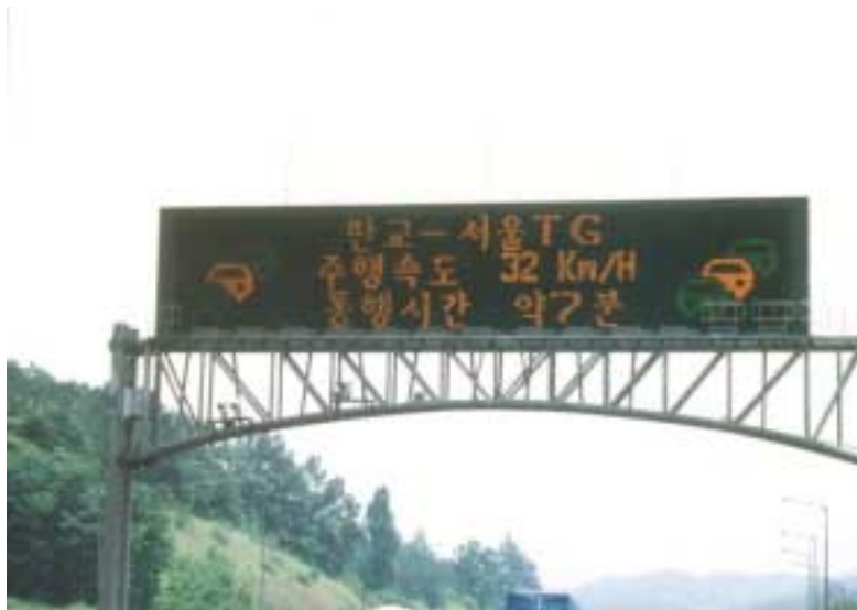
<그림 2-4> 경부고속도로 VMS 1 (통행시간표출)
