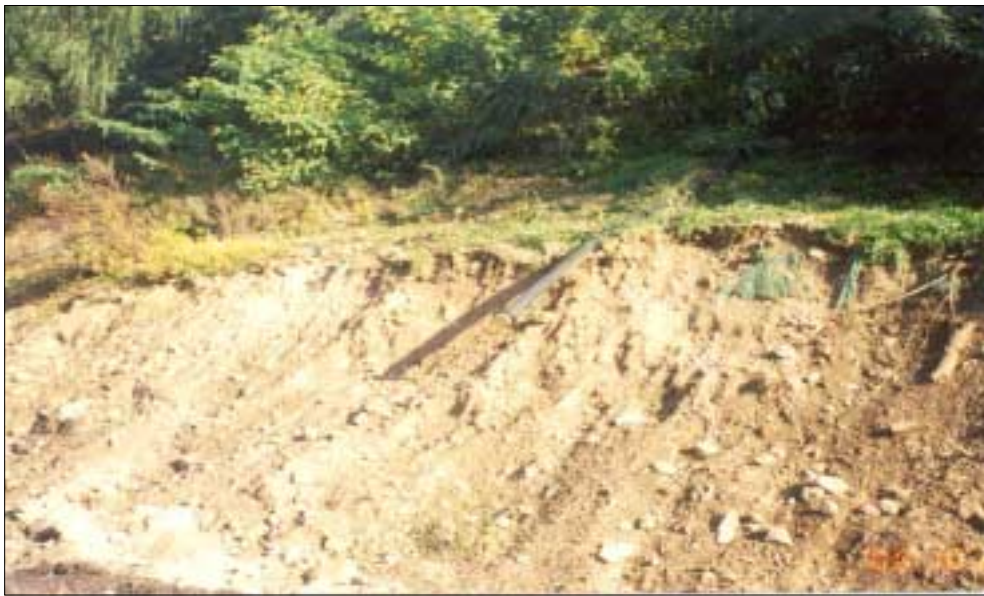
<그림 4-8> 사면 가스이송관의 설치
