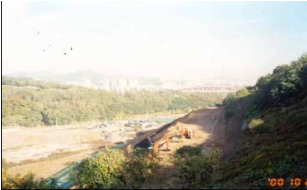
〈그림 4-10〉 제2매립지 불안정 사면의 정지 및 관리도로 공사
