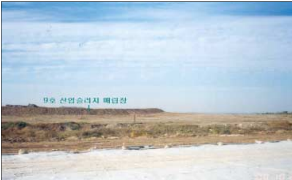
〈그림 4-11〉 제1매립지 9호 산업슬러지 매립장위의 성토작업 광경
