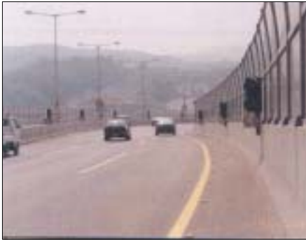
<그림 III-4> 내부순환로의 시거 불량지점의 예
