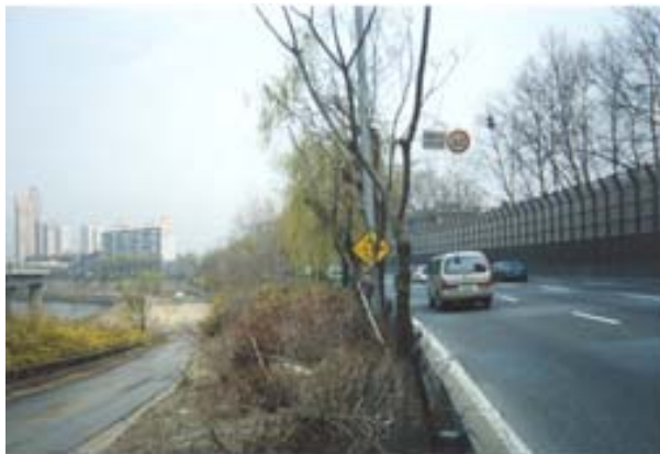
<그림 Ⅲ-16> 가로수가 가로등/표지판을 가리는 경우
