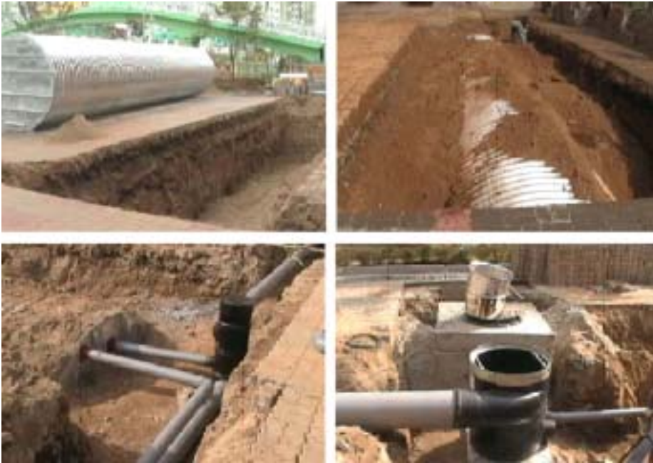
<사진 4-9> 갈매중학교 빗물저류조 공사
